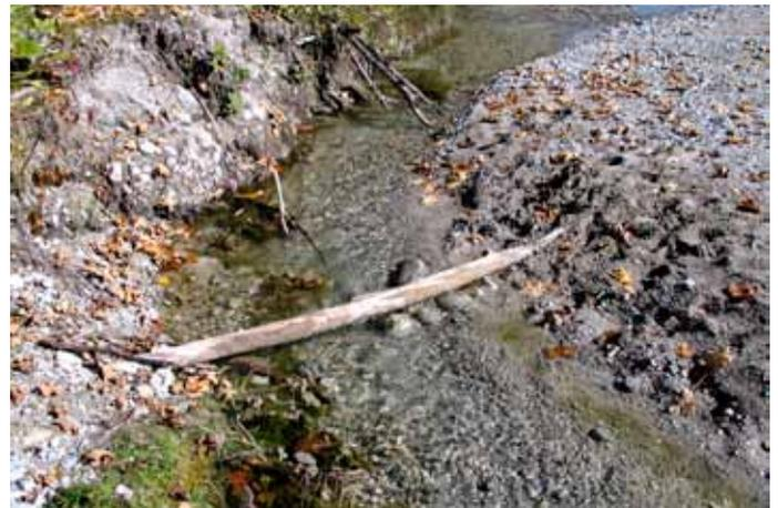
Abb. 3: Auf einer Wanderung hilft dir diese einfache Brücke weiter, aber als Widerlager dient nur etwas Sand. Beim nächsten Hochwasser schwimmt die Brücke weg!
