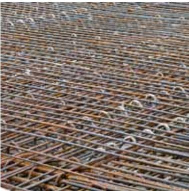
Abb. 41: Flechtwerk in einer modernen Stahlbeton-Brücke. Auf das Flechtwerk wird der Beton gegossen.
