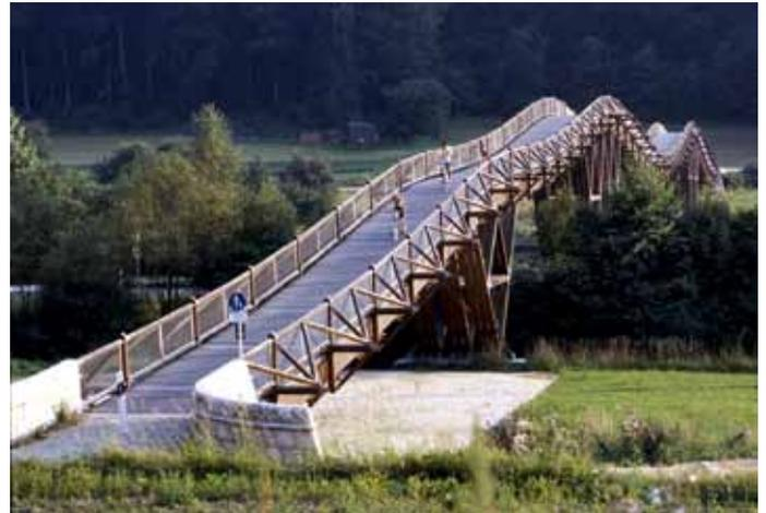
Abb. 42: Früher hätte man diese Fußgängerbrücke aus Stahlbeton gebaut, doch inzwischen probiert man andere Konstruktionen aus wie bei dieser Spannbandbrücke in Essing – ein bisschen Hängebrücke, ein bisschen Fachwerk und lustig zum Drüberradeln!
